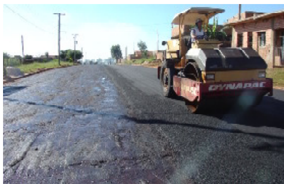
Máquinas trabalham em ritmo acelerado no Monte Mor
