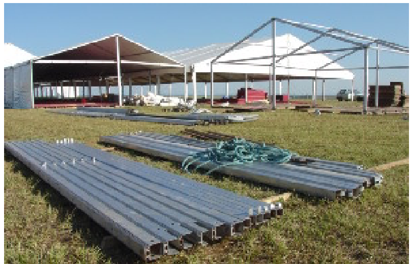
Estrutura do evento começou a ser montada no início da semana passada
