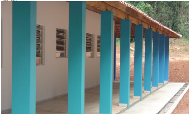
Escola do Meio Ambiente, em fase final de construção
