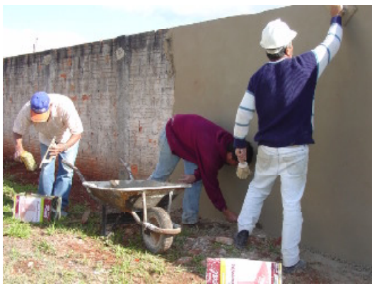
Reforma da UB do Jardim Cristina está em andamento
