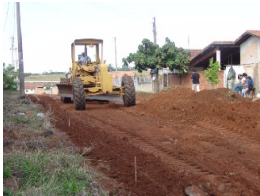
Maquinas trabalham na rua 4
