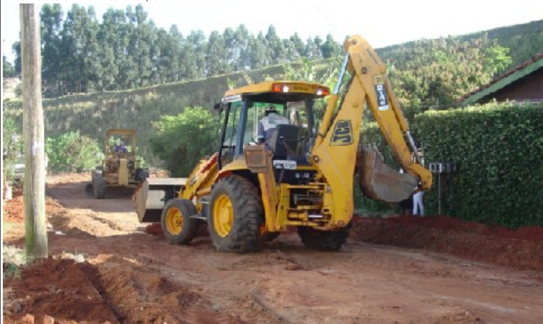
Ruas do Jardim Irajá também vão receber asfaltamento
