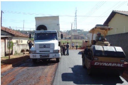
Cinco ruas da Vila Assunção foram asfaltadas
