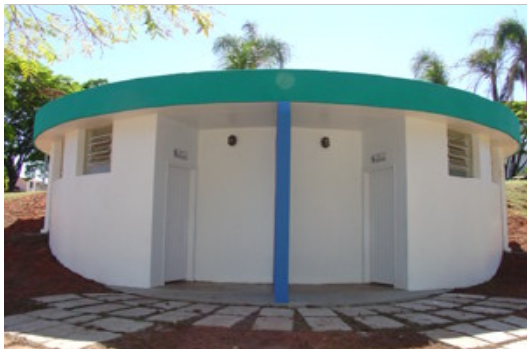
Reforma do banheiro deixou a praça mais bonita
