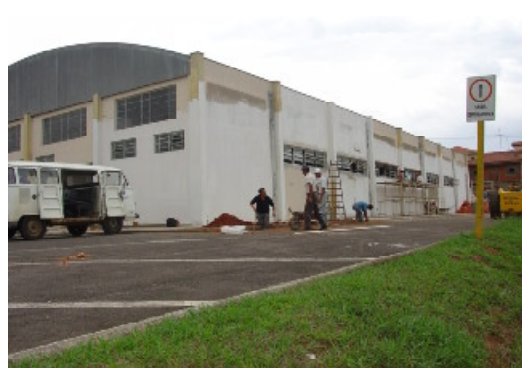
Obras da Vara Federal seguem em ritmo acelerado
