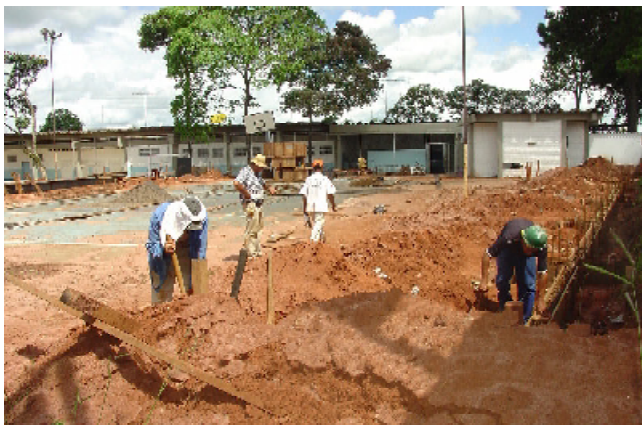
Obras no Angelino de Oliveira já começaram
