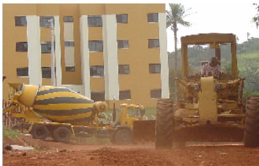
A entrada do Condomínio já se encontra asfaltada
