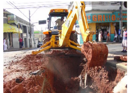
Prefeitura teve de interromper o trânsito no local
