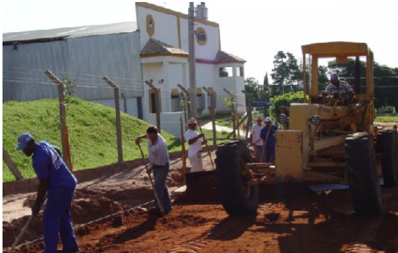
Obras estão sendo feitas em parceria com Associação do Distrito Industrial 3
