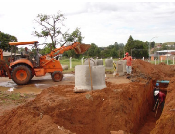
No total, serão construídos 160 metros de galerias
