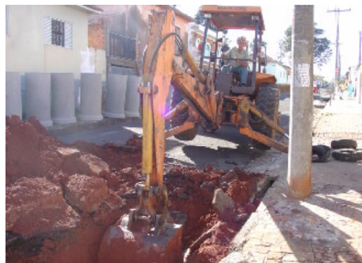
Obra vai completar sistema de captação
