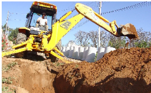
Depois das galerias, vem as guias e o asfalto
