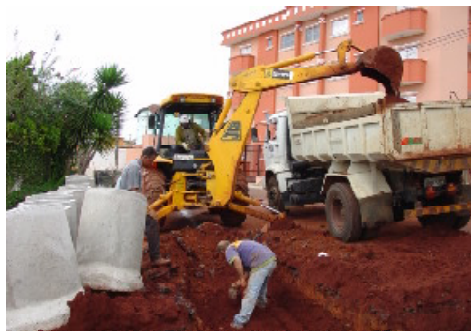
Obra vai evitar novos transtornos para moradores
