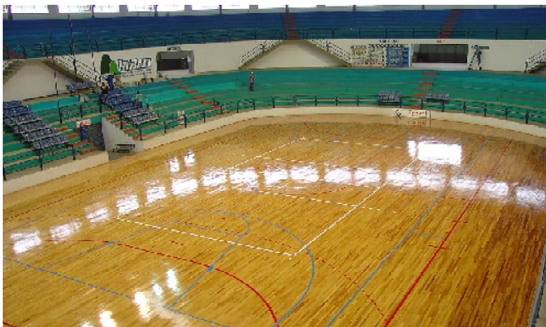
Novo piso já está pronto. Funcionários trabalham na pintura interna e externa
