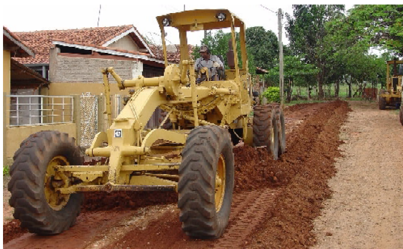
Máquinas da Prefeitura trabalham para levar o sonho do asfalto às ruas de Vitoriana
