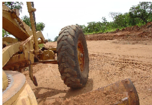
Obra vai facilitar acesso entre bairros
