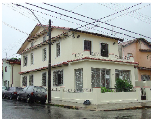
Prédio recebe últimos acertos antes de ser inaugurado
