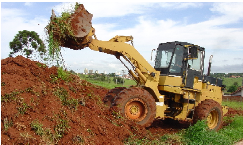
Serviço de terraplenagem será feito pela própria Prefeitura
