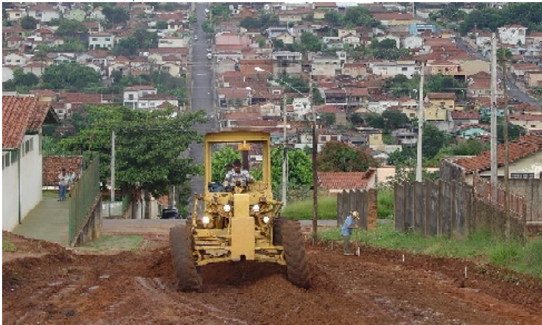
Rua Ulisses Grassi é preparada para receber o asfalto
