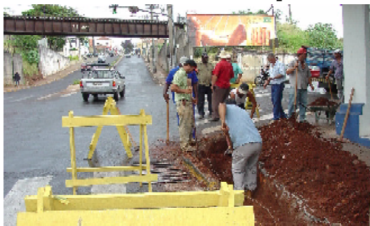
Trecho do pontilhão também será recapeado
