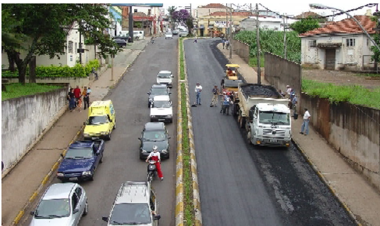
Equipe de asfalto da Prefeitura trabalha no recape da Major Matheus
