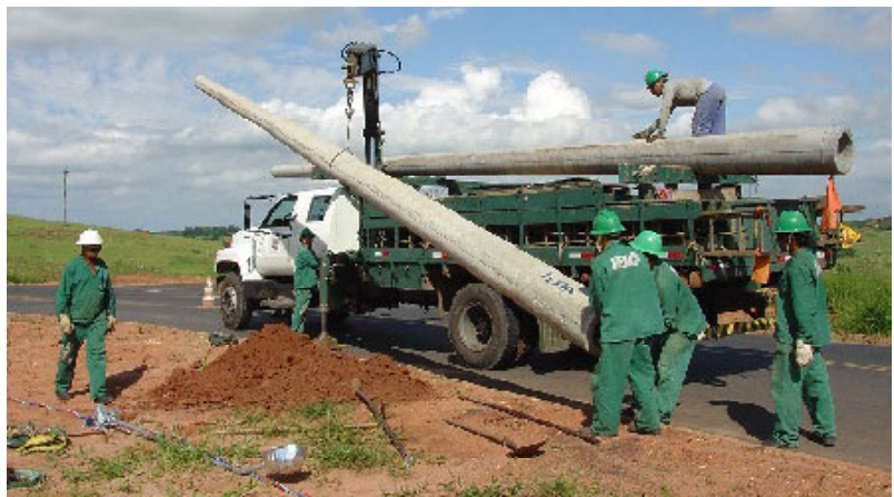
Funcionários da empresa contratada pela CPFL já concluiu o trabalho
