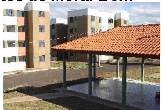
Condomínio foi capinado para receber moradores
