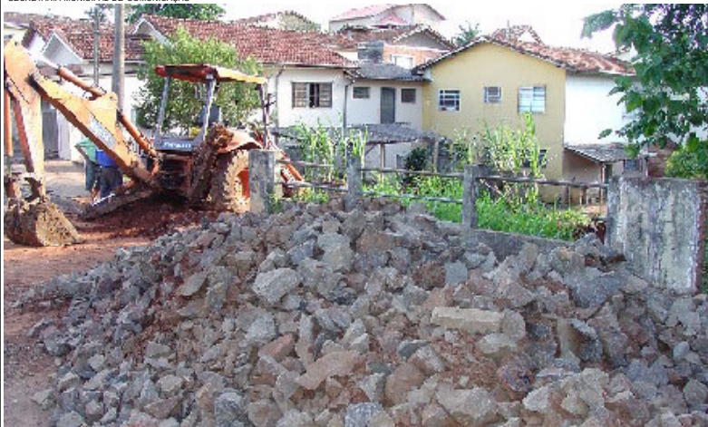
Prefeitura faz gabões de concreto no Córrego do Cortume
