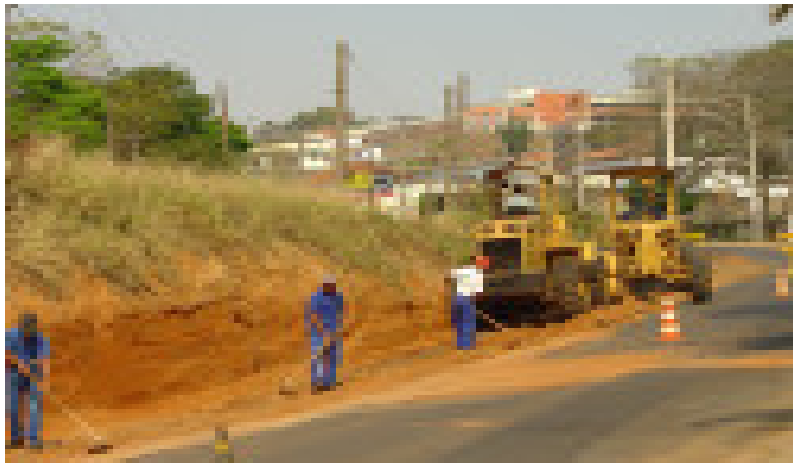
A obra aumentará em dois metros as margens da rua João Butignoli, em Rubião Jr.
