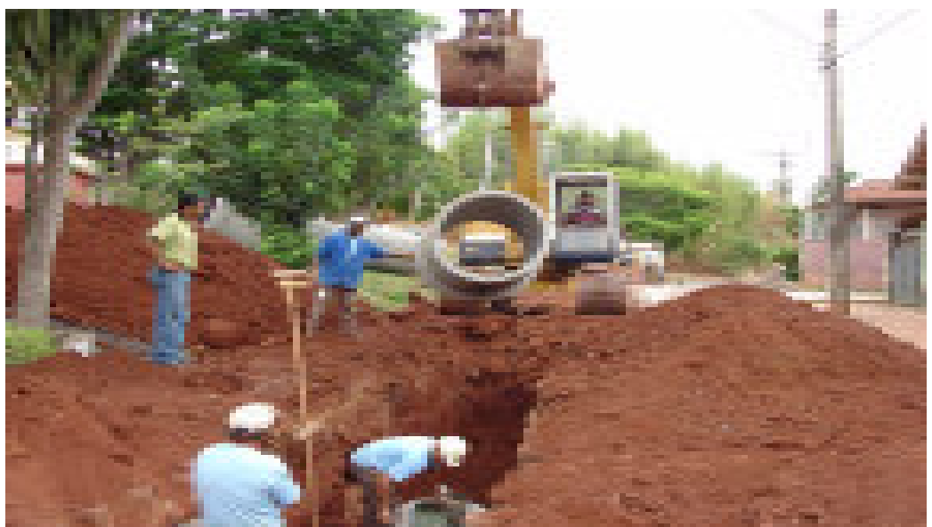
Avançam as obras de construção de galerias na região da Vila Rodrigues
