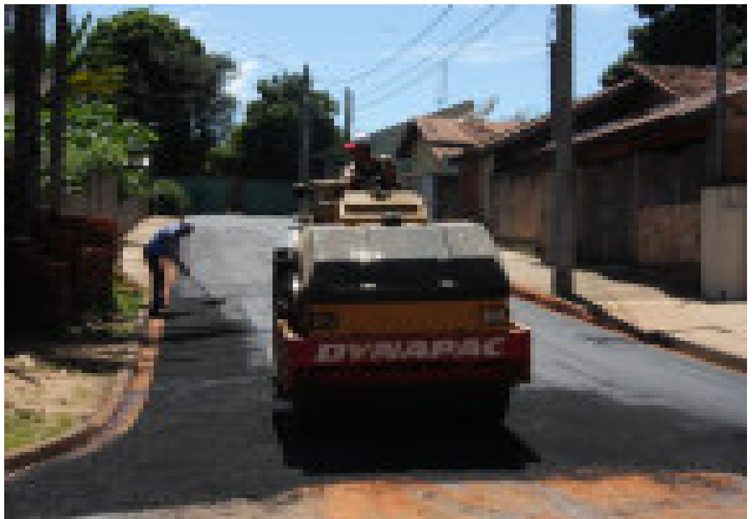
O Distrito de Rubião Júnior recebeu aproximadamente 10 mil m 2 de massa asfáltica
