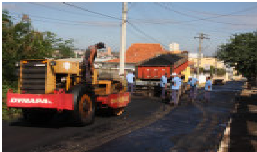
Prefeitura realizou recape asfáltico nas imediações da Vila Rodrigues
