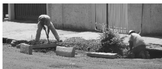
Obras no Jardim no Mirante
