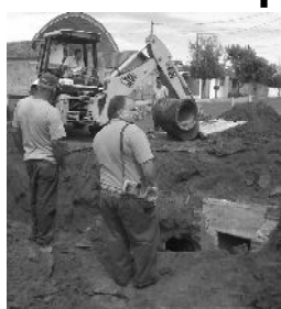
No Comerciários a retificação da rede de coleta de água pluvial
